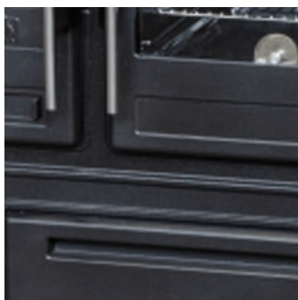
Façade tout fonte
